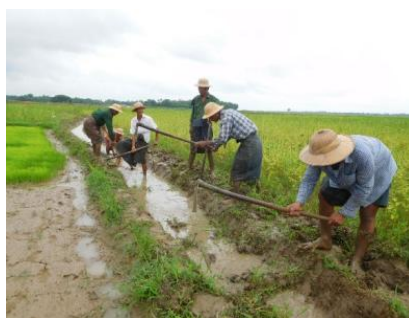
多様な作付けを実現する圃場内水路の建設・維持管理を協働で実施する
