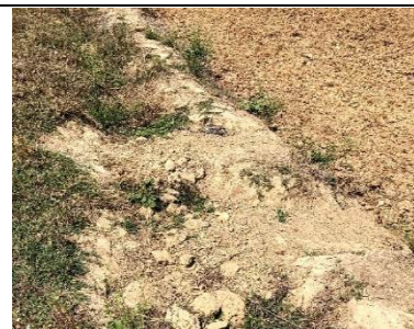
補修されず埋まっている3次水路
