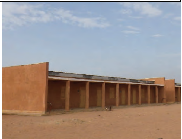
【No.15 CES Aéroport 2】先行案件による平屋校舎外観
