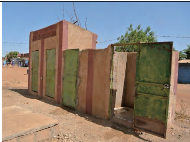
【No.27 Lossagoungou FA】既存トイレ棟外観
