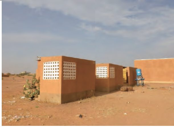
【No.15 CES Aéroport 2】先行案件によるトイレ棟外観
