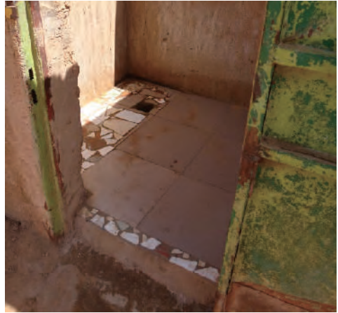
【No.27 FA Lossagongou】穴のみあいているトイレ
