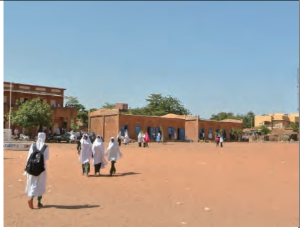
【No.26 Lazaret2 FA】建設予定地。既存校舎の向かいに新校舎を建設する。
