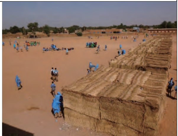
【No.16 CES Bassora】建設予定地。藁葺教室を移設して新校舎を建設する。
