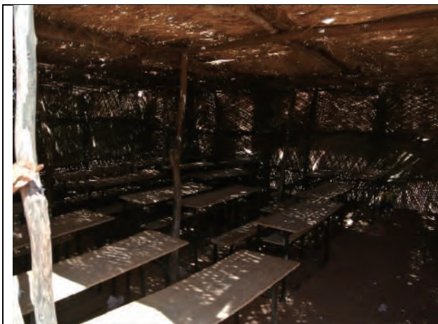
【No.17/18 CES Niamey 2000-I/2000-II】 暗い藁葺教室内部の様子。机上照度が一定でない。
