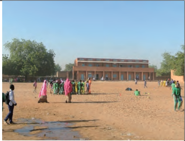
【No.25 CES Gawèye II】建設予定地。既存校舎の向かいに新校舎を建設する。
