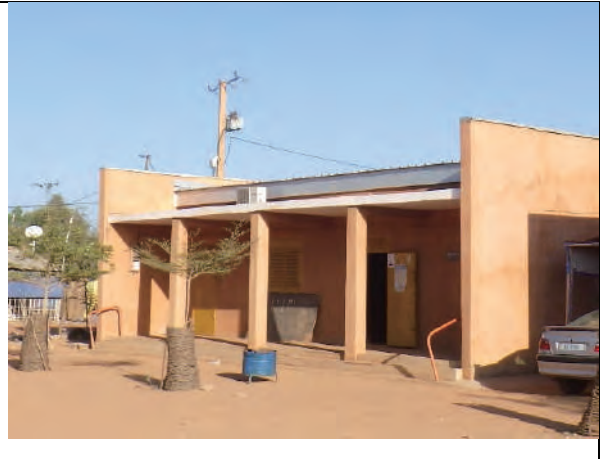
【No.23 CEG Nordiré】先行案件による管理棟外観
