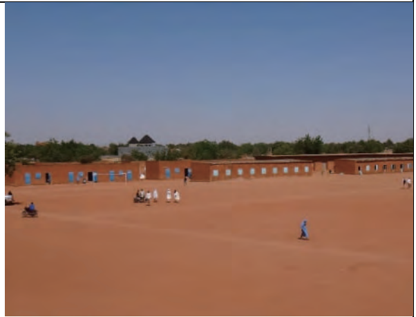
【No.13, 14 CES Aéroport 1/A, 1/B】土地が広く2校が併設されている。既存教室群の手前が建設予定地。
