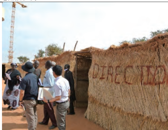
【No.2 CEG Koubia Kaina】建設予定地。藁葺教室を移設して新校舎を建設する。
