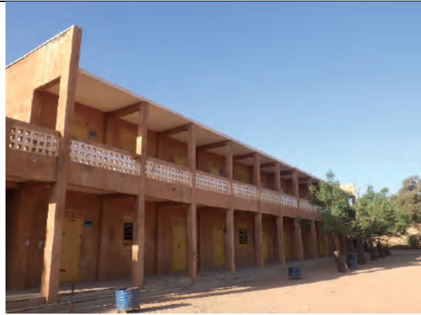
【No.23 CEG Nordiré】先行案件による校舎外観
