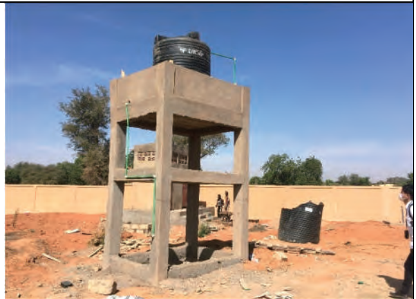
ユニセフ支援で建設中の給水タンク
