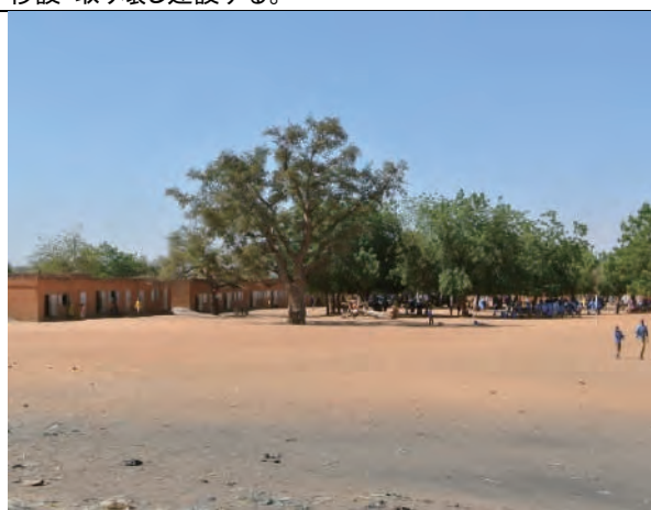
【No.21 CES Saga 2】建設予定地。既存校舎の向かいに新校舎を建設する。
