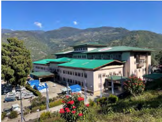
写真 3 : 東部地域中核病院 (ERRH) 外観
