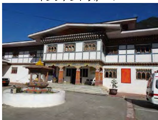
写真 16 : ルンツェ県病院外観
