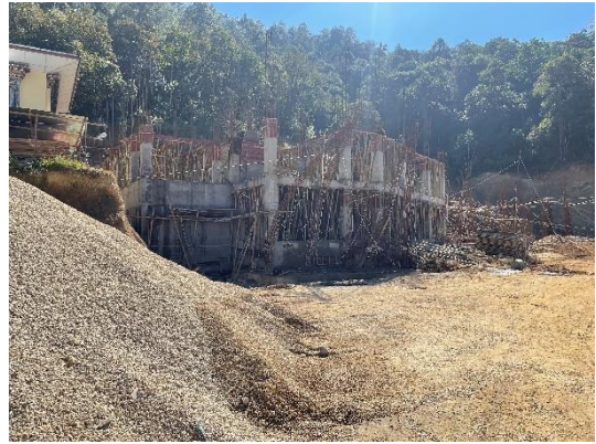
写真 2 : 建設中の東部地域母子保健病院 (2022 年 11 月) 左に見える建物は元王室ゲ ストハウスで同病院の一部として改修予定
