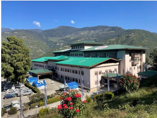
写真 3 : 東部地域中核病院 (ERRH) 外観
