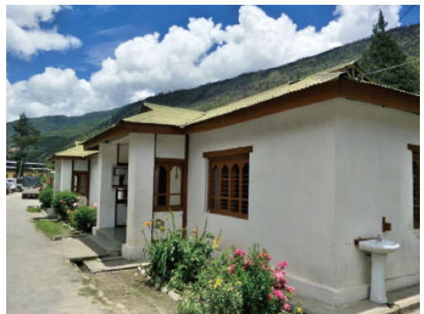
写真 6 管理棟。既存病院は築 50 年以上が経過しているが、病院スタッフが壁の塗り替えを行うなどして使用している。
