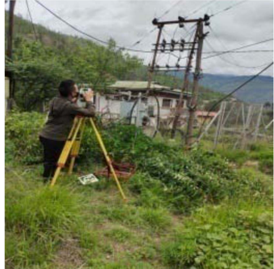
既存変圧器 1*250KVA、11KV
