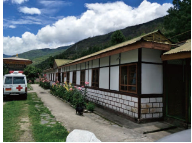
写真8 病院車が停まっている。結核患者の検体を RCDC に送る場合は、既定のパッケージを用い、病院車を使用している。
