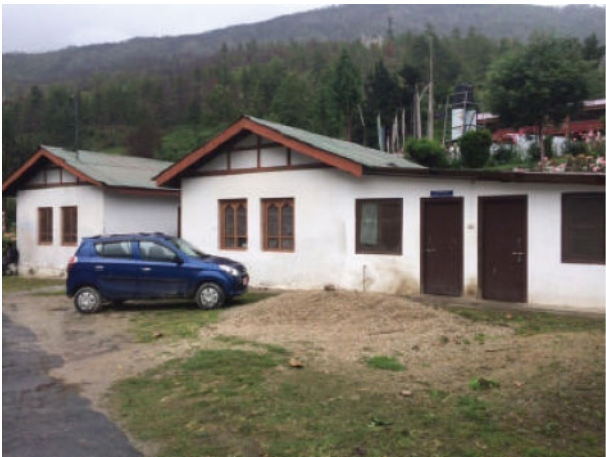
写真 5 キッチン。既存病院の施設は、倉庫や会議室、患者家族宿泊所など診療用途以外のサポート施設として利活用することも検討が必要。
