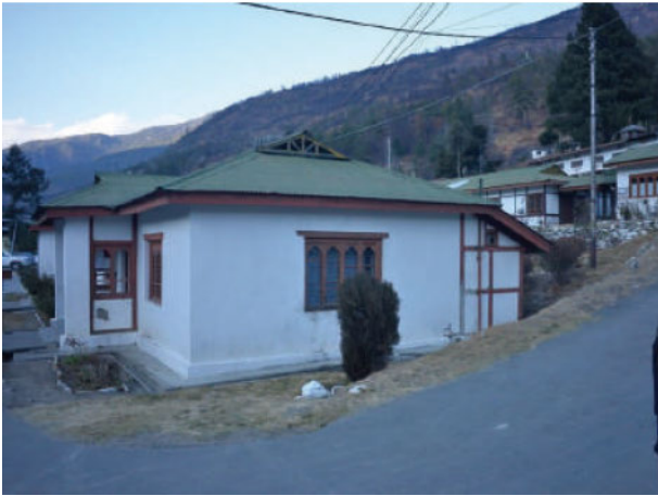
写真 3 建設候補地は既存病院と離れていることから、効率的な連携および動線について明らかにする必要があります。
