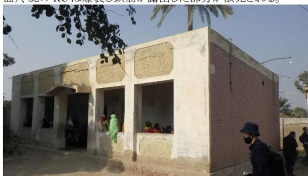
SU02 GGPS Lutuf Hussain Talpur: 既存校舎外観。床スラブ(外壁面)、底のRCは爆裂。パラペット部には亀裂が見られる。
