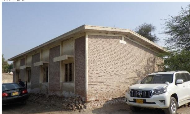
SU04 GGPS Khairo Indhar: 既存校舎外観。床スラブ(外壁面)のRCは爆裂。屋根スラブ端部はクラックが散見される。
