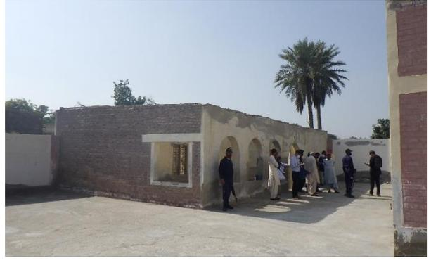
同左: 既存校舎 2 外観。屋根がすべて崩壊。壁にはクラックが散見される。狭小な建設用地のため解体する必要がある。
