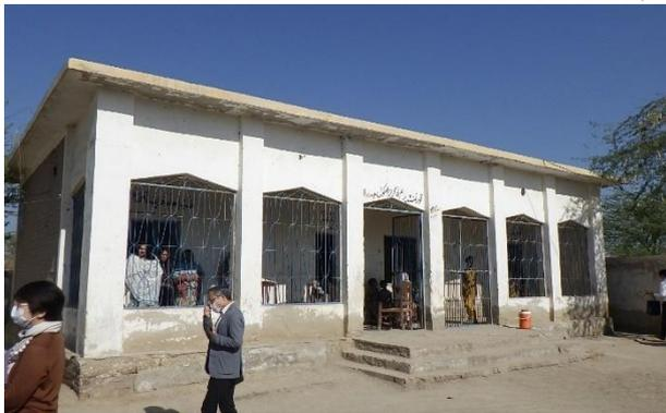
NF08 GGPS Ali Murad Chang: 既存校舎外観。屋根スラブ先端にクラックあり。床スラブ(外壁面)の一部でRCが爆裂。
