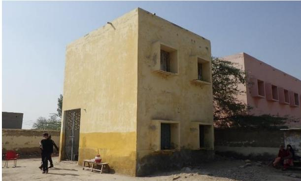
NF01 GGPS Rahim Chand: 既存校舎外観。出窓(庇)は、RC が爆裂。建物本体には大きな損傷は見られない。
