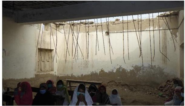
同左: 天井が崩落し、鉄筋が露出した教室内部(建替えが必要)。
