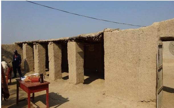
NF06 GGPS Wahid Bux Khaskhaly: 既存校舎外観。仮設の屋根は一部穴が開き、崩壊寸前のため補強木材で支持されている。
