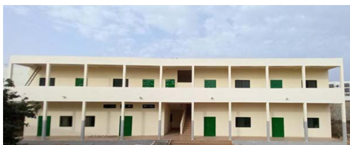
Figure 9 : Six salles de classe construites
