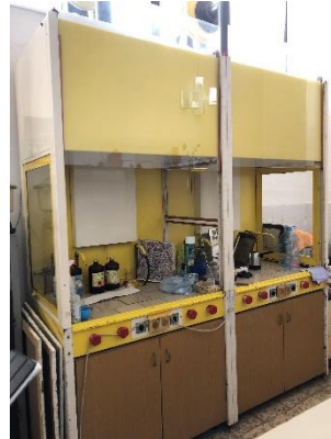
写真-10: 保存・修復ラボラトリー 故障している既存機材
