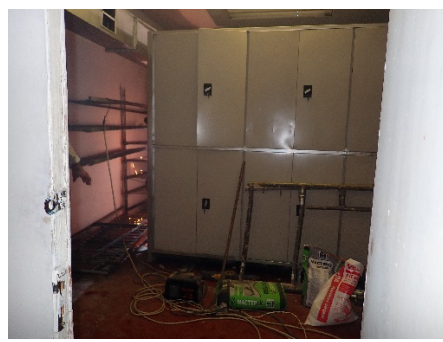
写真-6 5階建て建物の3階部分、現在改修中
