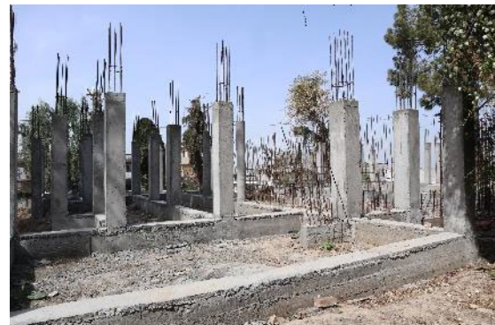
【写真 12 建設中の公会堂】 すでに着工され、基礎と柱の工事が行われている。
