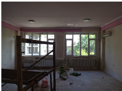
写真-9 3階建ての建物の3階部分、現在改修中
