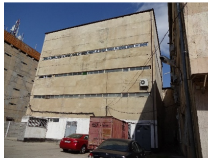
写真-2 国立文書館の5階建て建物の外観
