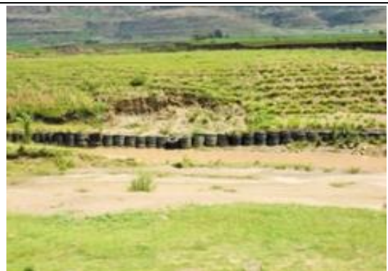
古タイヤによる護岸工 (レソト)
