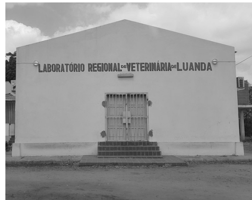
④ルアンダ州獣医学ラボ (外観)
