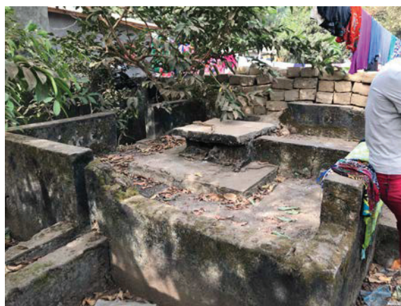
本プロジェクト建設予定地周辺の井戸 国家水資源整備局 (SNAPE) により整備された井戸。本調査において地下水水質検査の採取ポイントであり、検査の結果飲料水基準を満たしている。(2020年1月25日撮影)
