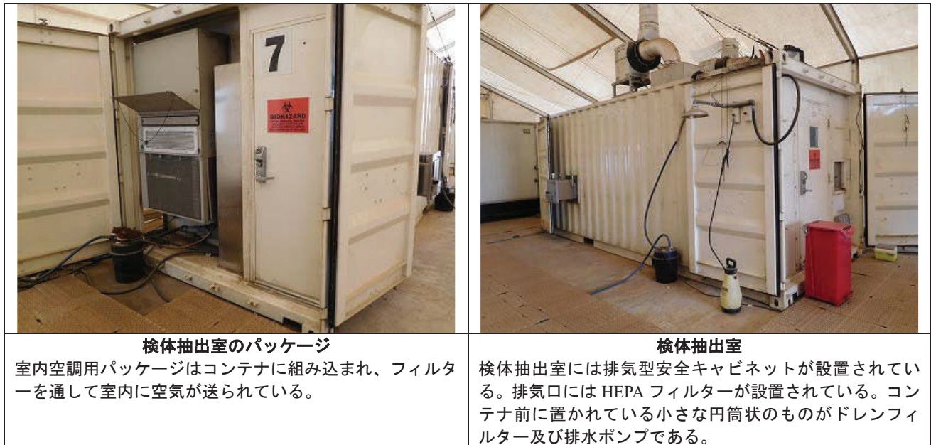
図 2-1-11 INSP ノンゴ分室空調換気設備
