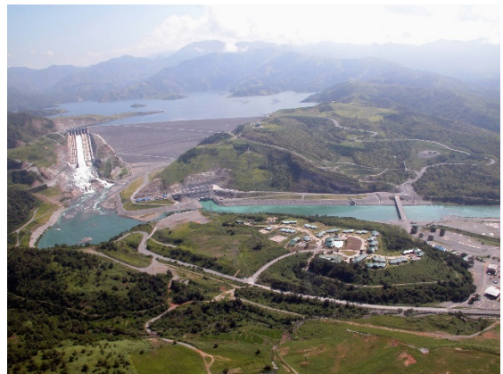
図 3.5-1 サンロケ水力発電所
