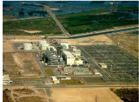
図 3.5-4 フーミー発電所群
