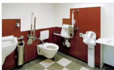
Hình S-14: Nhà vệ sinh đa chức năng 7
