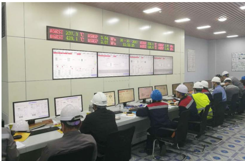
図 3.3.1 モンゴル石炭火力発電所の中控科技納入の DCS 中央管理室
