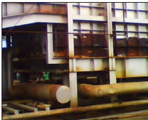
Fig. 3-31 HRSG Casing Overheating
