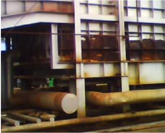
HRSG Casing Overheating (#1HRSG, #2HRSG)
