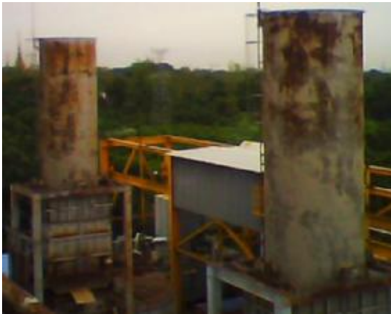
バイパスダンパガス漏れによりバイパススタック過熱 (#1HRSG, #2HRSG)
