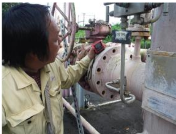
ガス漏洩診断風景
