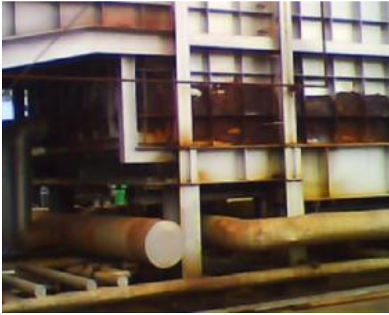
HRSG ケーシング下部過熱 (#1HRSG, #2HRSG)
