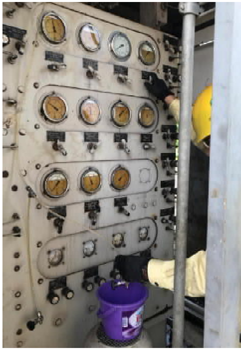
潤滑油サンプリング風景 採取場所：#3GT 圧力計取出部
