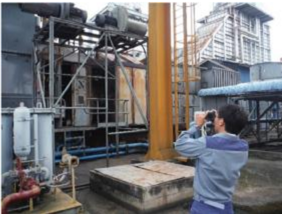
サーモグラフィによる漏洩診断風景
