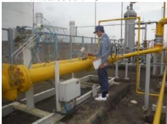
ガス漏洩診断風景
