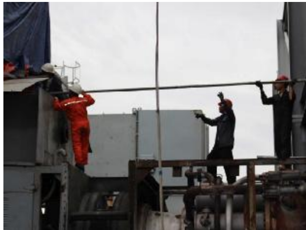
図：定期点検実施状況
