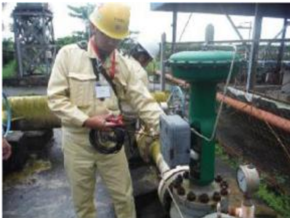
ガス漏測定風景
