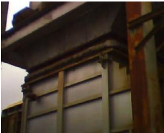
バイパススタック伸縮継手ガス漏れ (#1, 2, 3 HRSG)
