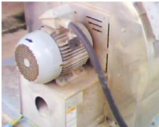
#2GT 潤滑油ミストセパレータファン用電動機
