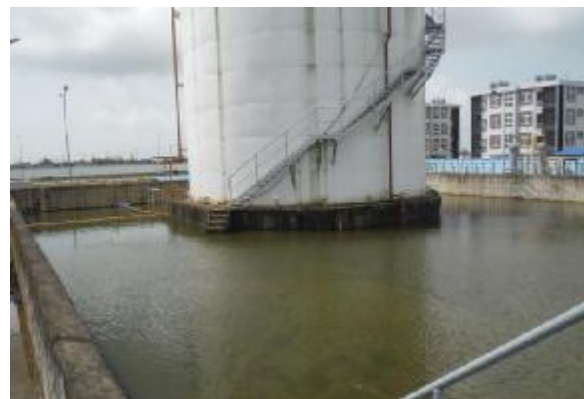
雨水を溜める燃料タンクヤード
