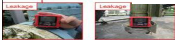
ガス漏れ状態のままでの危険運転
