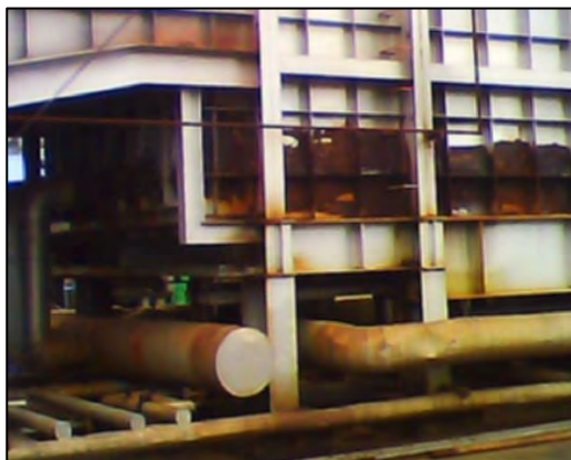
図 3-31 HRSG ケーシング下部 過熱
