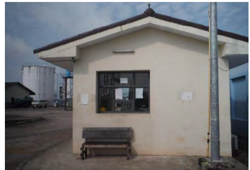
図 3-18 守衛所(ティラワ発電所)
