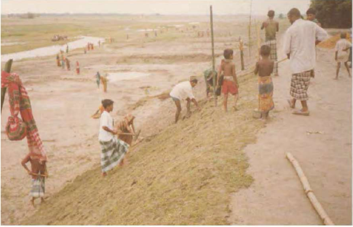
চিত্র-৩ এলসিএস দ্বারা বাঁধের ঢালে ঘাসের চাপড়া লাগানো হচ্ছে। লাগানোর পূর্বে পার্শ্বঢাল ড্রেসিং ও কম্প্যাকশন করতে হবে।
