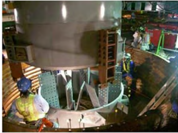
図 4.5.7 鋼管ソケット接合の概念図および現場写真
