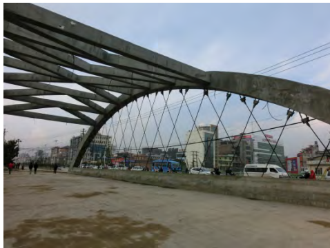
RC アーチ橋
