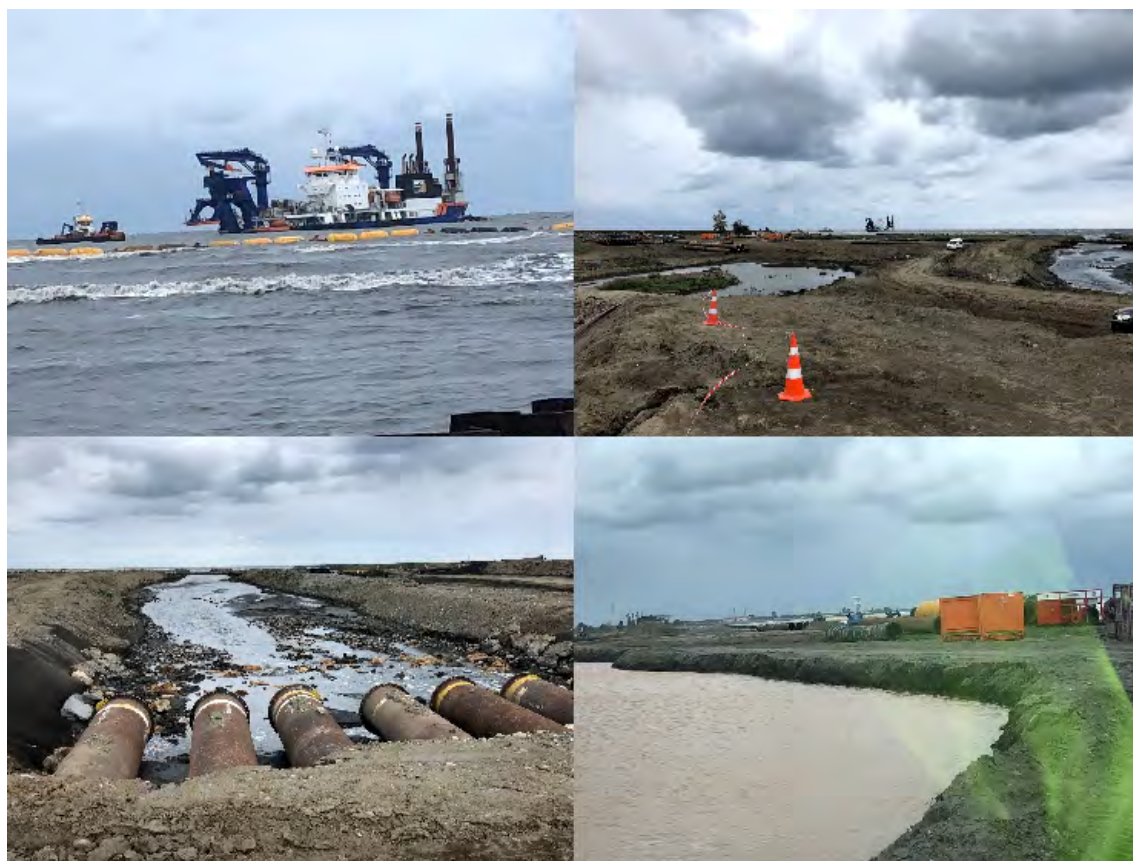
図 20 アナクリア港の建設工事の現況 (2018年9月現在)
