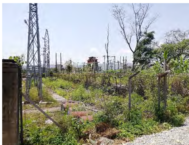
図 4.3-13 Pokhara 変電所構内の蓄電池設置候補地
