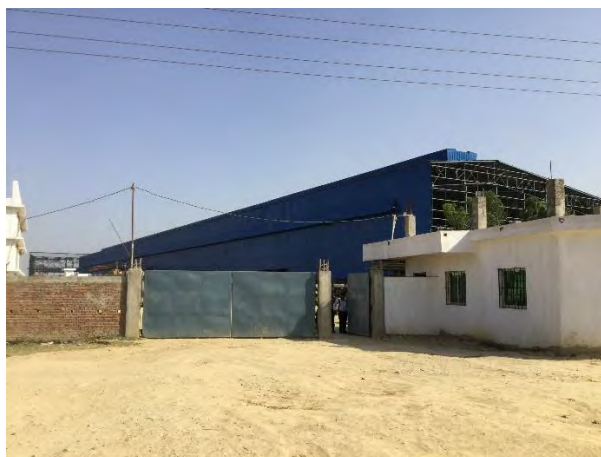
図 4.2-35 建設中の大規模鉄鋼工場
