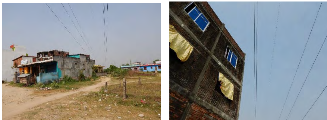
図 4.2-25 Kohalpur—Bhurigaon の既設送電線下の状況
