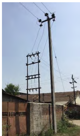
図 2.2-6 角型コンクリート柱
