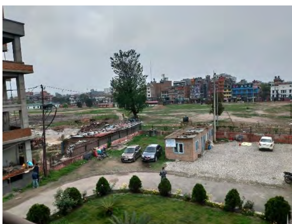
図 4.3-5 蓄電池設置候補地(K3 変電所)
