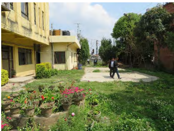
図 4.3-9 Baneswar 変電所構内の空き地
