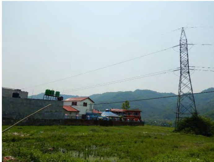
図 4.2-7 送電線の分岐箇所の既設鉄塔
