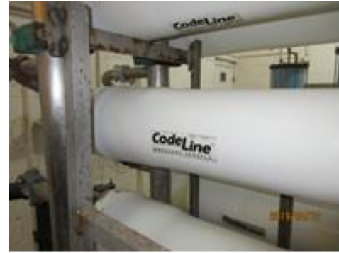
圧力容器：米国 Codeline 社製
