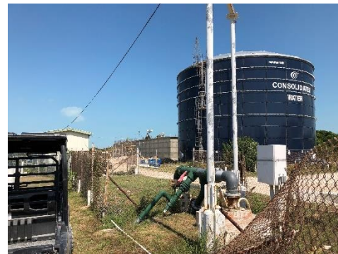
生産水貯水槽 (奥が建設中の 2 号機の貯水槽)
