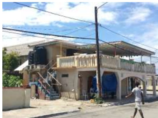
雨水タンクが設置された家屋
