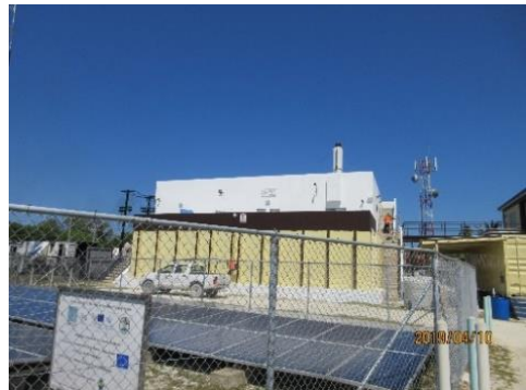
生産水貯水槽 (1階部分が貯水槽、2階に淡水化施設)
