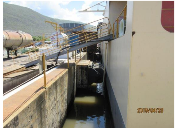
岸壁との接岸部
