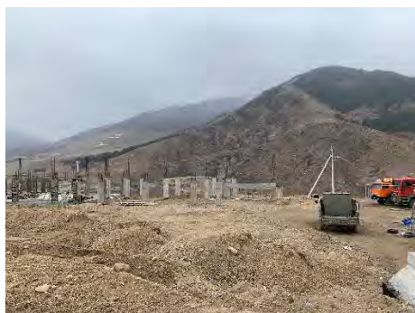
建設中の道の駅
