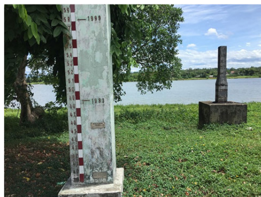
無堤区間（中流部、市街地）
