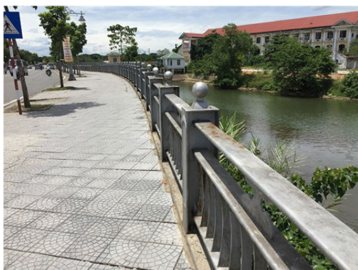
無堤区間（中流部、市街地）
