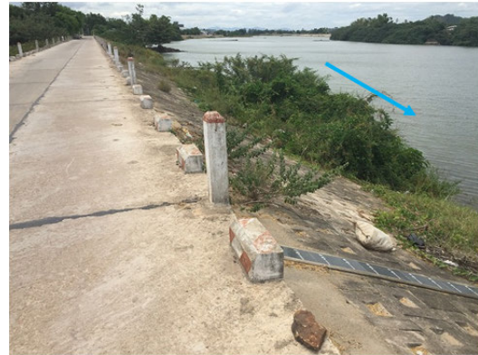
堤防区間（下流部）
