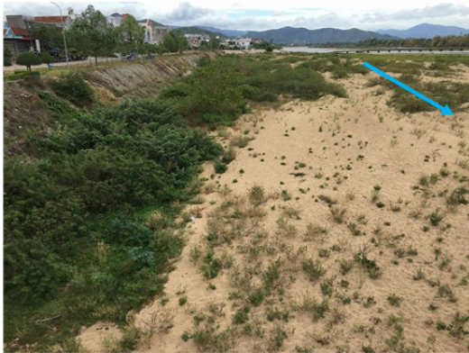
無堤区間（中流部）
