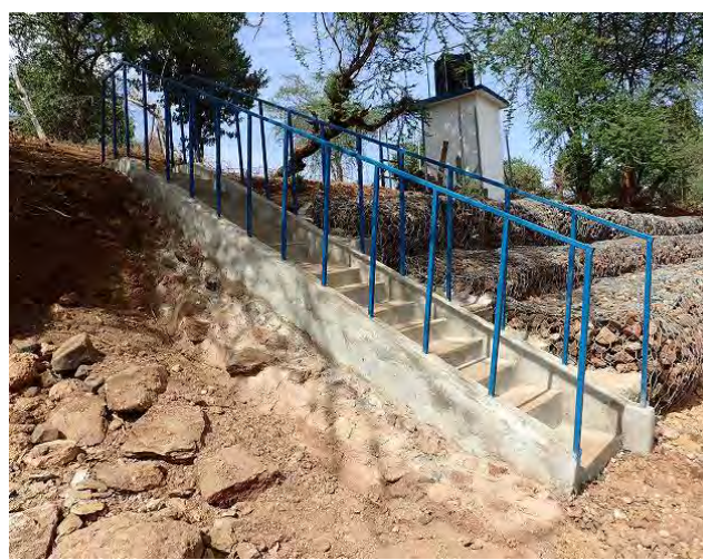
階段工および護岸工の設置：4F10（2019/03/01）
