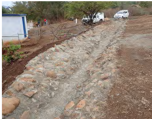
排水路の建設：4BE10（2019/03/02）
