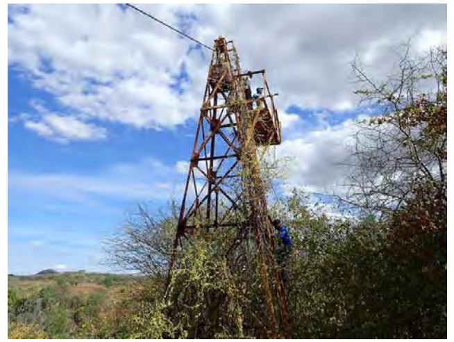
流観用ケーブル支持用のタワー (4F13、2017/06/14)
