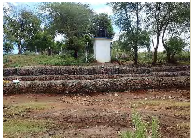
護岸工設置状況 (完成後) (4F10、2019/06/12)
