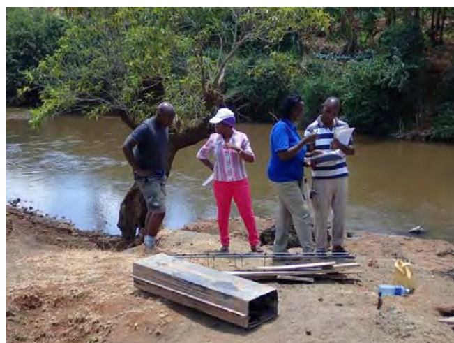
水位標ポスト型枠及び鉄筋 (4BE10、2018/02/22)
