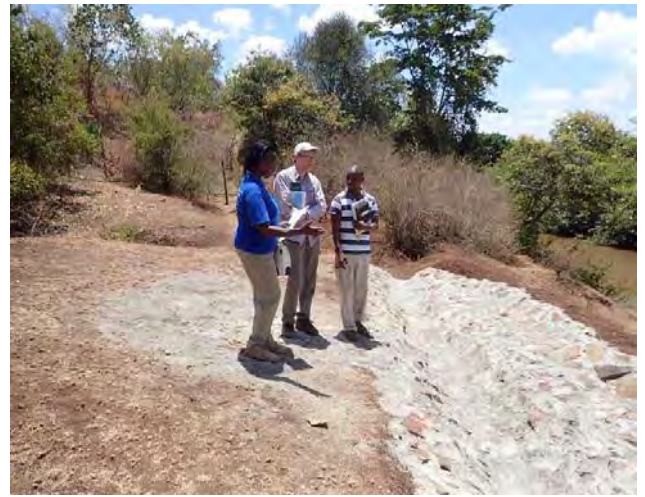
排水路建設状況 (4BE10、2018/02/22)
