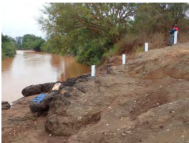
水位標の設置：4BE10（2019/03/02）
