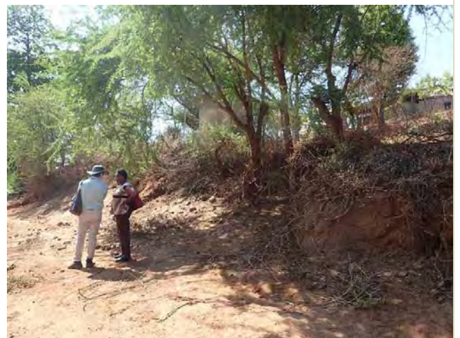
観測小屋前面の河岸浸食状況（4F10、2017/09/27）
