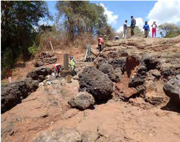
水位標ポスト建設状況 (4BE10、2018/02/22)
