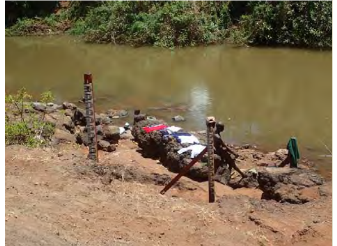
修繕前の水位標（4BE10、2017/04/05）
