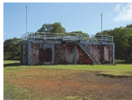
消火訓練施設
