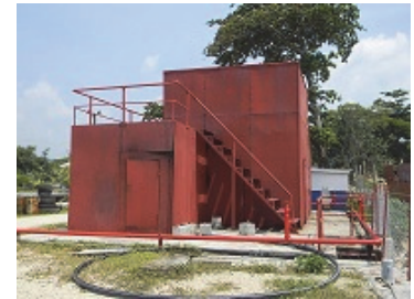
消火訓練用設備 (JICA 供与)
