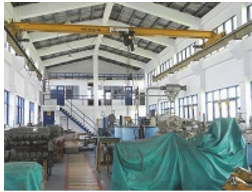
JICA 供与エンジンプラント 実習室全景
