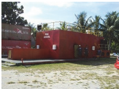
消火訓練施設
