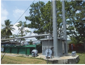
荷役訓練用設備
