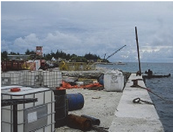
PII ドック予定地 (手前岸壁から奥のクレーンまで 400m)
