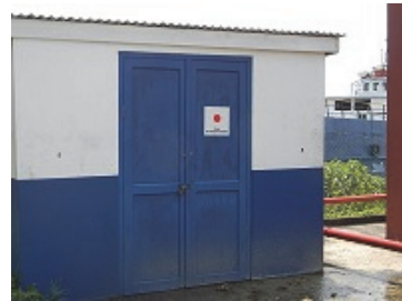
消火装備用倉庫 (JICA 供与)
