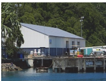
ポートビラ中央ふ頭の JICA 支援倉庫
