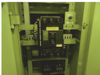
要交換のスイッチボードの サーキットブレーカー (Caroline Voyager)
