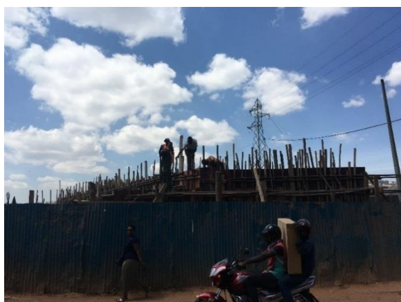
建設中のニャブゴゴ新設橋
