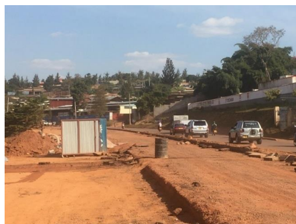
実施中の KN3 道路の拡幅工事
