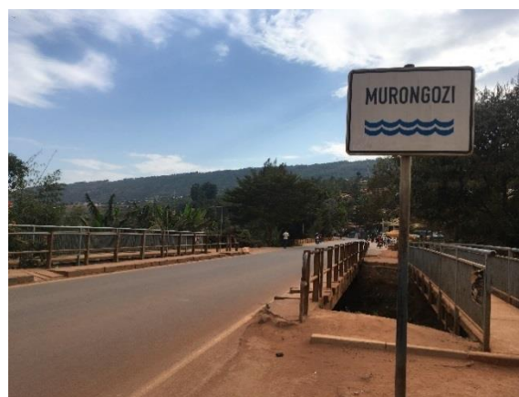
ムロンゴジ川にかかる既設橋（2車線）
