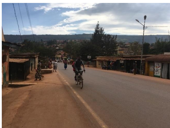
現況（2車線、歩道無し）
