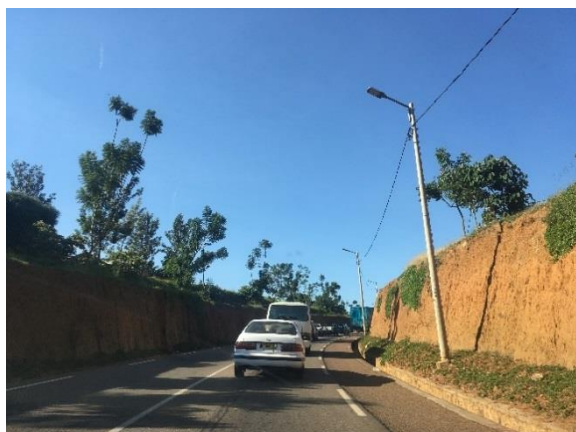
NR5 の現況（2 車線）
