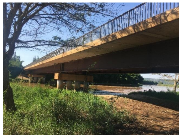
既設のアカゲラ橋（2 車線）
