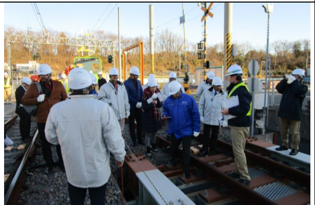
1/18 鉄建建設 視察
