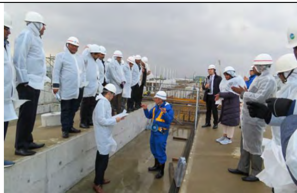
12/14 北陸新幹線延伸工事現場 視察
