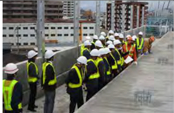
11/19 北陸新幹線高架橋工事 視察
