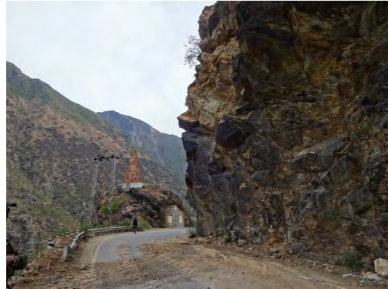
落石発生後の現場(N35_8)
