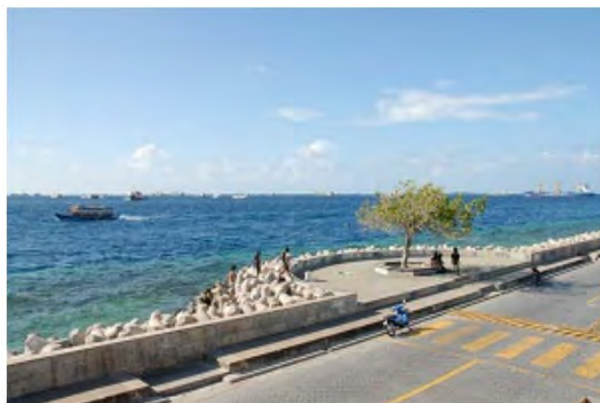
図 4.59 日本政府により建設された強靱な護岸工 (出典:外務省 HP)
