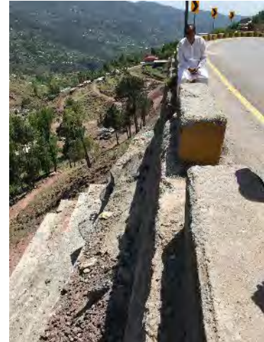
図 4.49 道路谷側の斜面における擁壁の好ましくない施工状況 (N75_5 斜面)
