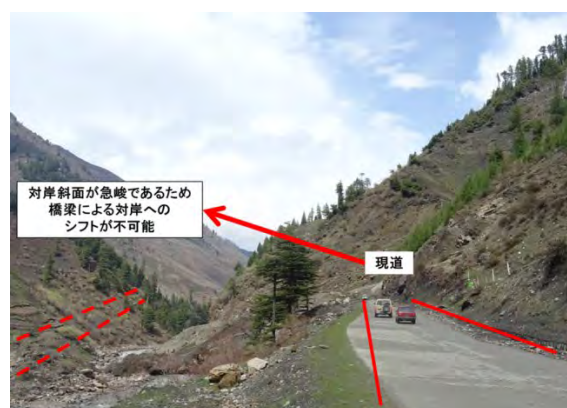
図 4.69 対岸部分が急峻な地形であり同等の道路建設が不可能(橋梁等による迂回路建設が不可能)な箇所の例(N15_8) (出典:調査団)
