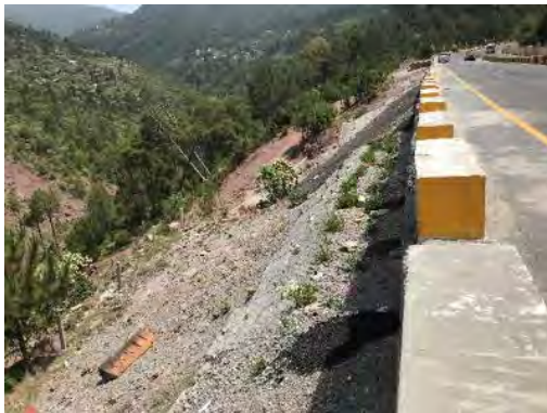
図 4.48 道路谷側の斜面における好ましくない盛土施工状況(N-75)
