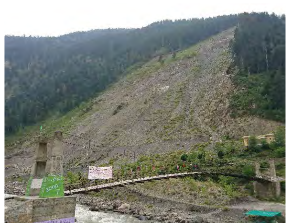
写真6 斜面崩壊箇所(N-15)
