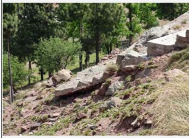
図 4.49 道路谷側の斜面における擁壁の好ましくない施工状況 (N75_5 斜面)
