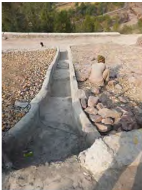
図 4.43 道路谷側に設置された表流水排除工(左)と道路を横断するボックスカルバート工(右):いずれも表流水の減勢処理が実施されている
