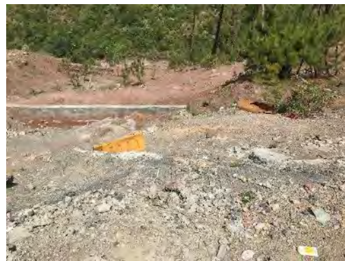
図 4.48 道路谷側の斜面における好ましくない盛土施工状況(N-75)
