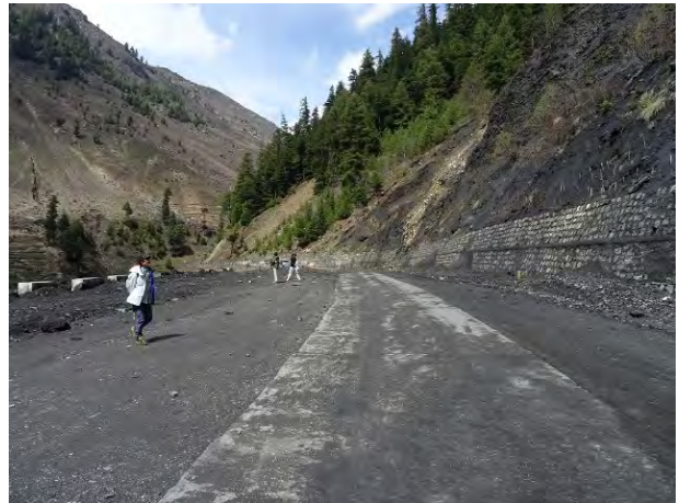
写真8 N-15沿線の斜面崩壊箇所の調査
