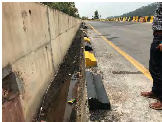
図 4.50 側溝の水たまり(左)と、片勾配による路面排水状況(右) (N75_2 斜面)
