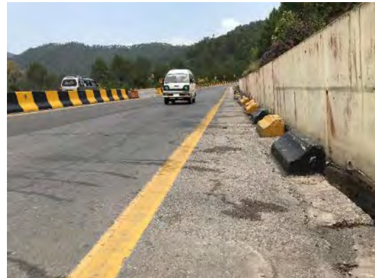
図 4.50 側溝の水たまり(左)と、片勾配による路面排水状況(右) (N75_2 斜面)
