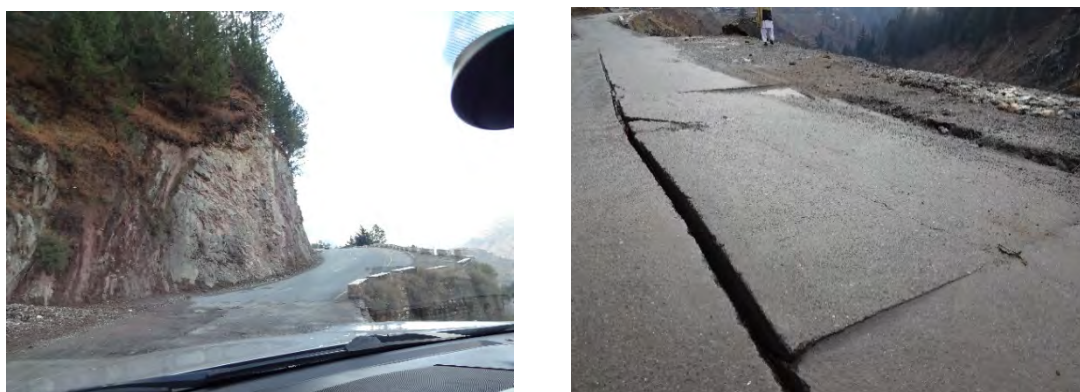
図 4.35 不適切な斜面切土の勾配(左)及び盛土(右)の例(出典:調査団)
