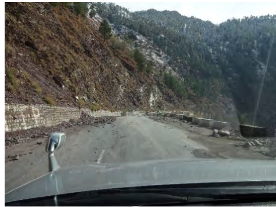
道路脇に多く見られる崩壊土砂
