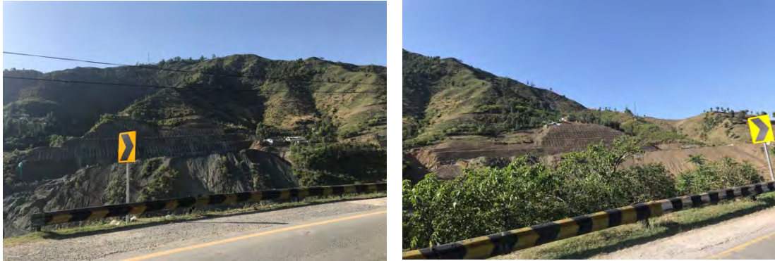
図 4.52 中国企業(中国交建有限公司)による N-35 沿いの切土斜面安定化対策の状況(斜面上部からベンチカットで段を設けて切土した後、法枠を立ち上げる形で斜面に設置している状況。場所は、N-35、Havelian から Abbottabad の間
