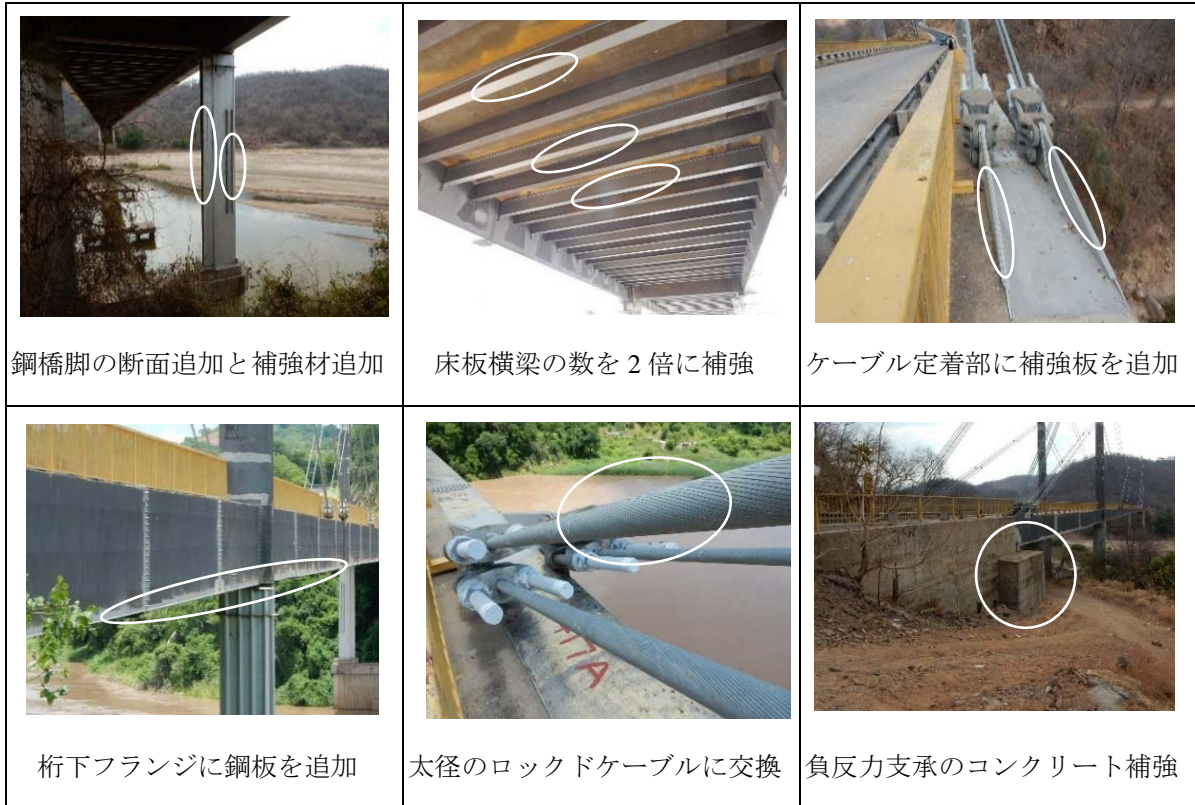
写真 5.2-2 補強部分の例
