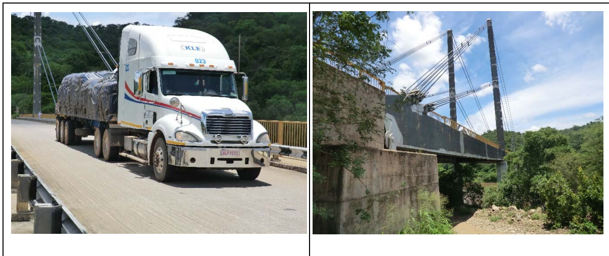
写真 5.2-3 路面状況と橋梁側面
