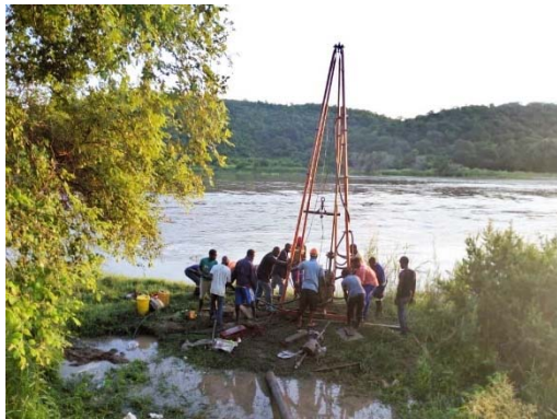
写真 5.1-8 BH-1（右岸側）の調査状況
