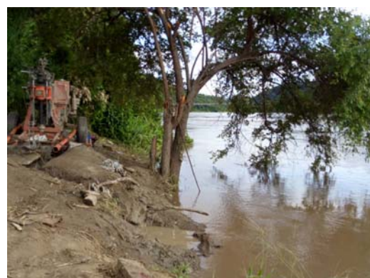
写真 5.1-13 BH-1'（右岸側）の水位状況
