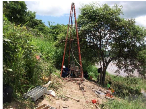
写真 5.1-9 BH-1'（右岸側）の調査状況
