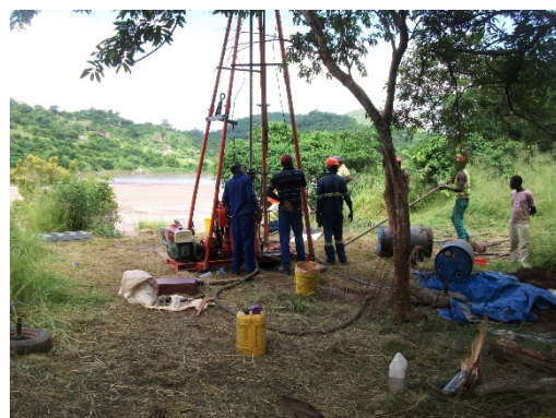
写真 5.1-11 BH-3（左岸側）の調査状況
