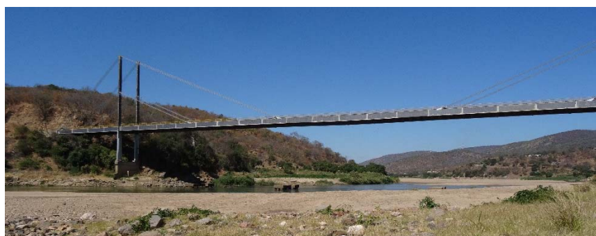
写真 5.2-1 ルアングワ橋
