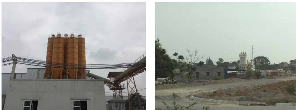
Hình 11.2-2 Trạm trộn bê tông (1) và (2)
