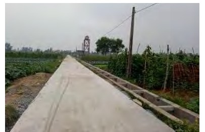
Hệ thống thoát nước được xây dựng tại xóm 2 (20/11/2018)
