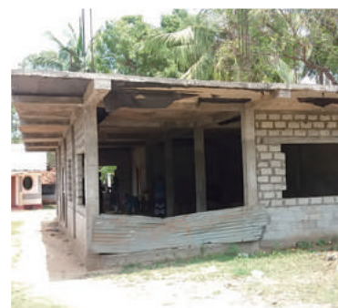
建設中の開発組合の食品加工所
