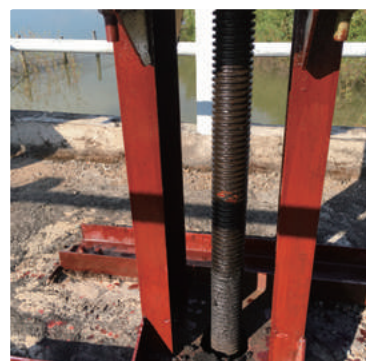
灌漑用の貯水池とダム頭首工(コントウム省)
