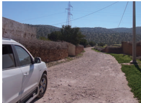
整備前の道路
