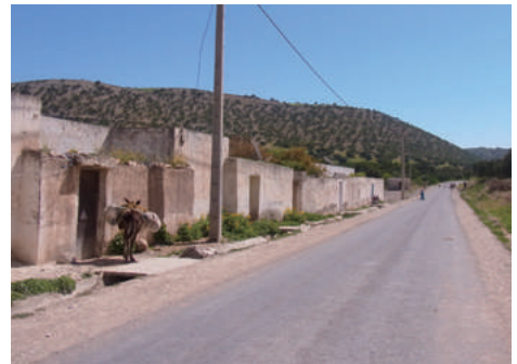
整備後の道路
