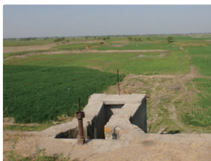
ダムの取水設備
