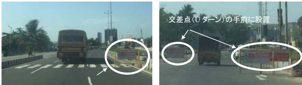
図 2.1.3 バリケードの設置
