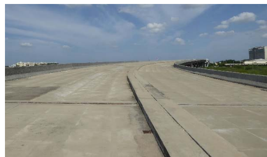
図 6.5.15 MJB101 と区間 4 終点施工済み橋梁(コンクリート舗装)
