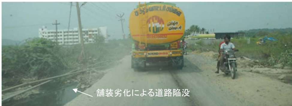
図 2.2.18 舗装の劣化による道路陥没
