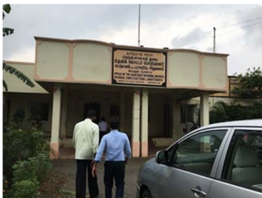
道路局ティルバルール地域道路現場事務所 出典:JICA 調査団
