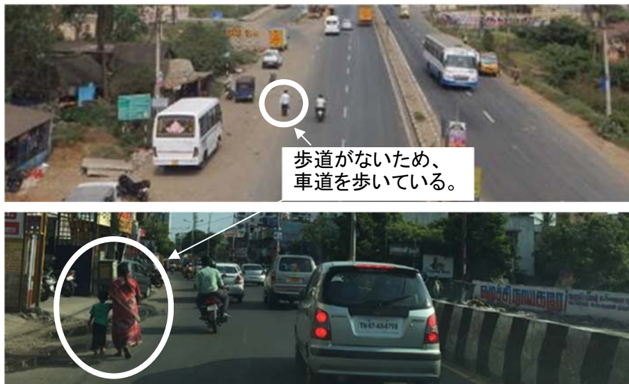
図 2.2.12 歩道未整備の問題
