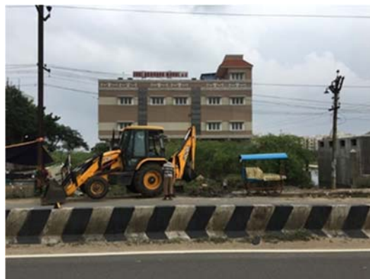
側溝の土砂排除作業
