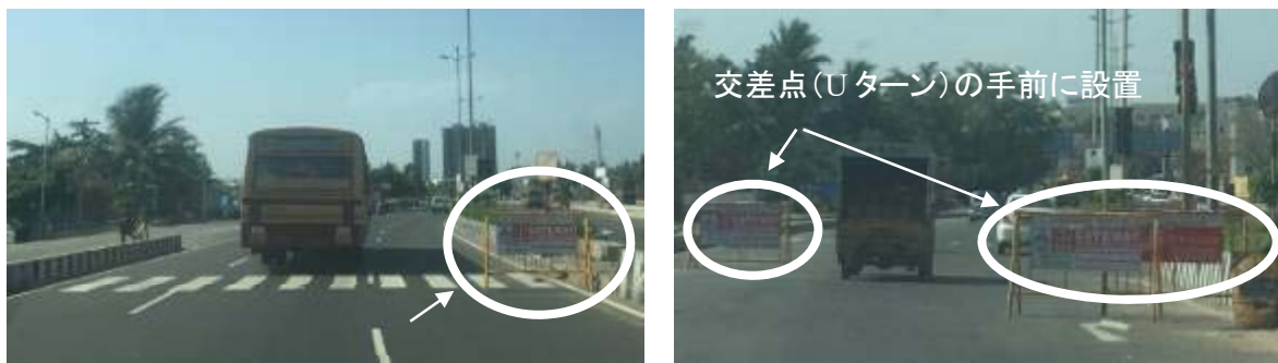
図 2.1.3 バリケードの設置
