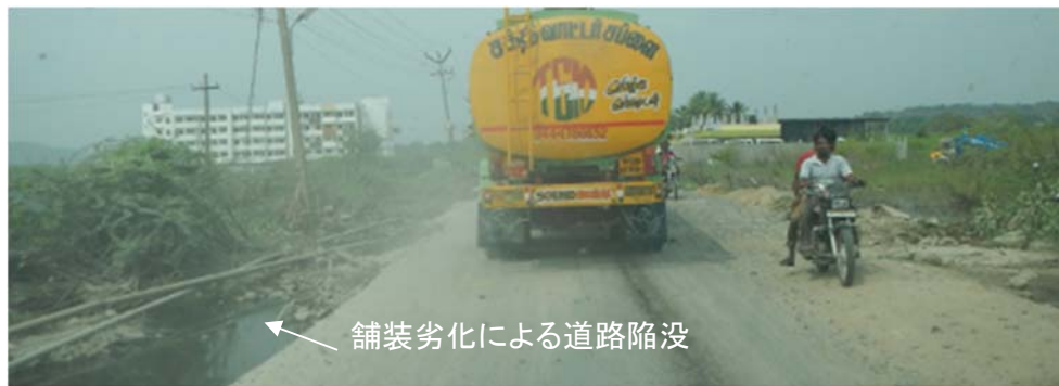
図 2.1.18 舗装の劣化による道路陥没
