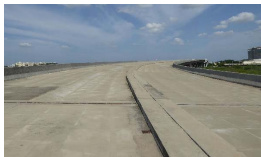
図 6.5.15 MJB101 と区間 4 終点施工済み橋梁(コンクリート舗装)
