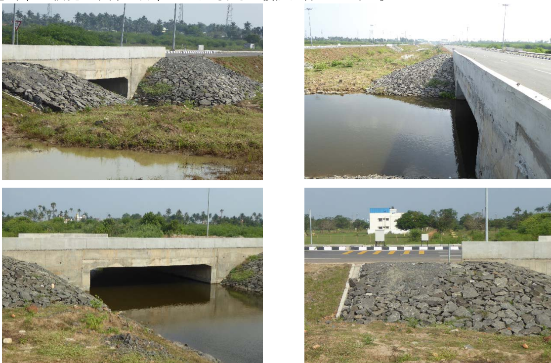
図 6.4.22 Box Culvert(外環状道路)
