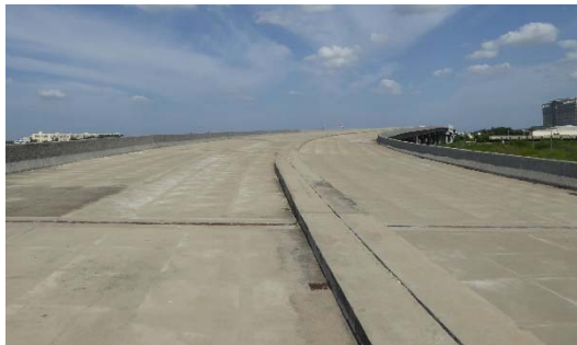
図 6.4.6 区間 4 終点施工済み橋梁(コンクリート舗装)
