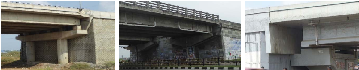
図 6.4.4 インドにおける混合橋脚の採用事例
