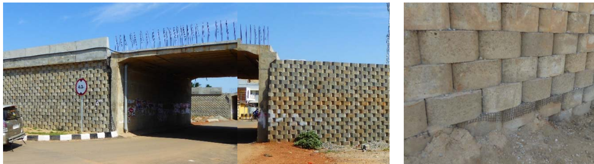
図 6.5.16 外環状道路における VUP 形式(ボックス、ブロック壁の採用)
