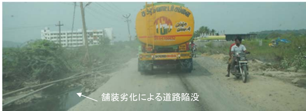
図 2.2.18 舗装の劣化による道路陥没
