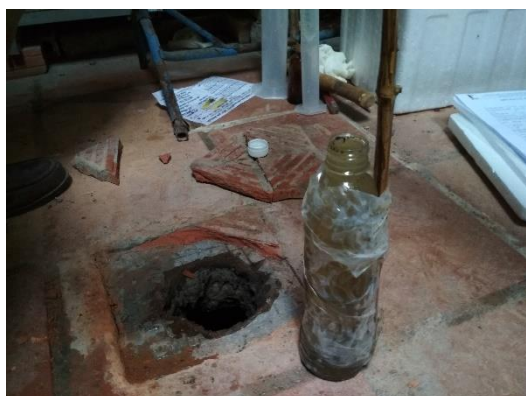
Ảnh 2-3 Lấy mẫu nước thải đầu ra từ bể tự hoại tại Hà Nội (nhà riêng, ngày 16/01/2018)
