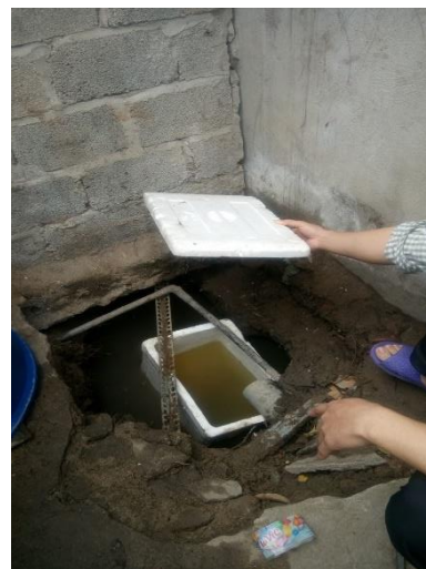
Lấy mẫu nước đã xử lý từ bể tự hoại
