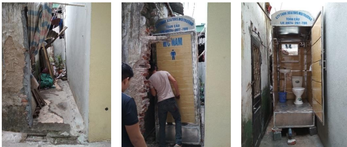
Ảnh 2-5 Lắp đặt một toilet tạm tại điểm khảo sát tại Quận Thanh Trì, Hà Nội (HN2TR1)
