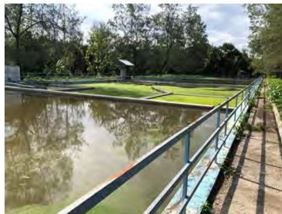
汚水処理施設
