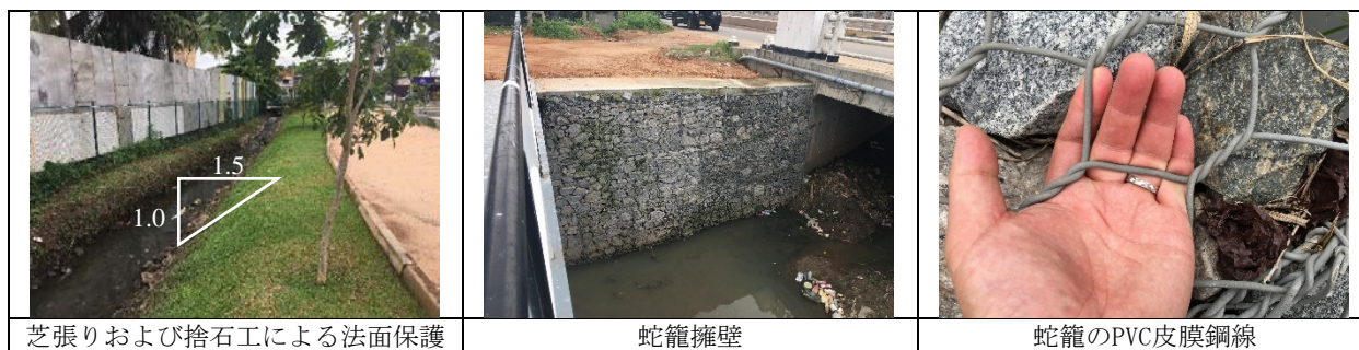
写真 6.7.1 対象地域における一般的な法面保護工
