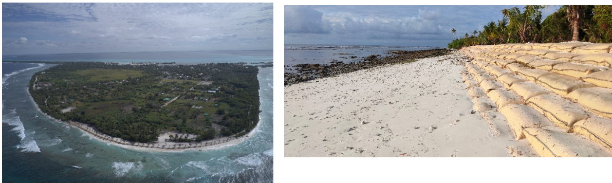
図 4.2.7 緊急事業として MNPHI によって整備中のサンドバッグによる護岸(2022 年 9 月時点)
