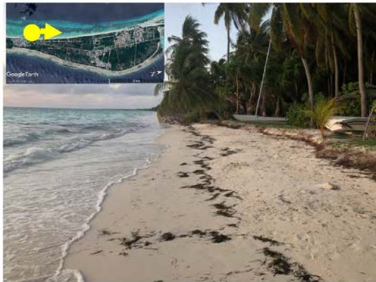
(ラグーン側(中部)の漁港北側の侵食)
