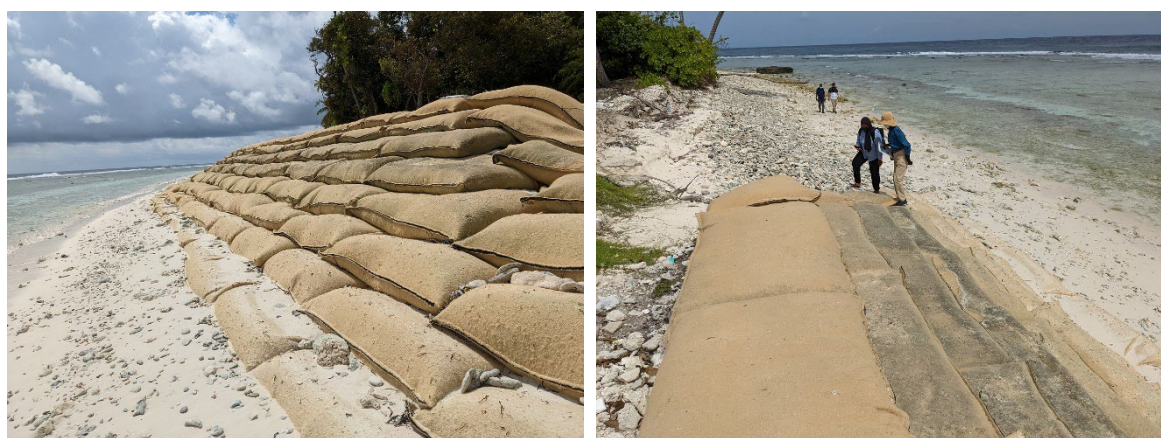
図 5.8.34 Meedhoo 島の既設護岸の設置状況
