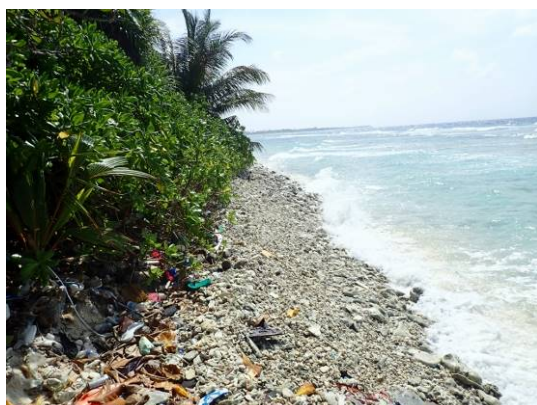
(P3 から北側：侵食状況)
