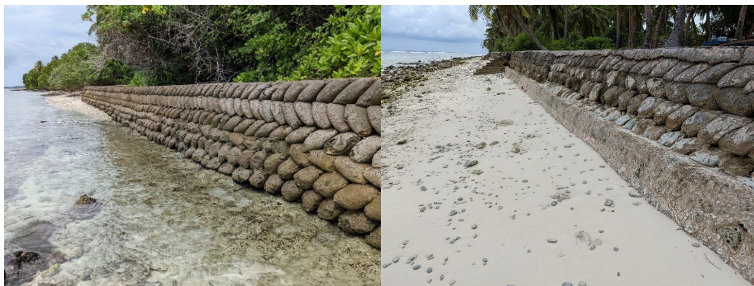
図 5.8.33 Gan 島の既設護岸の設置状況
