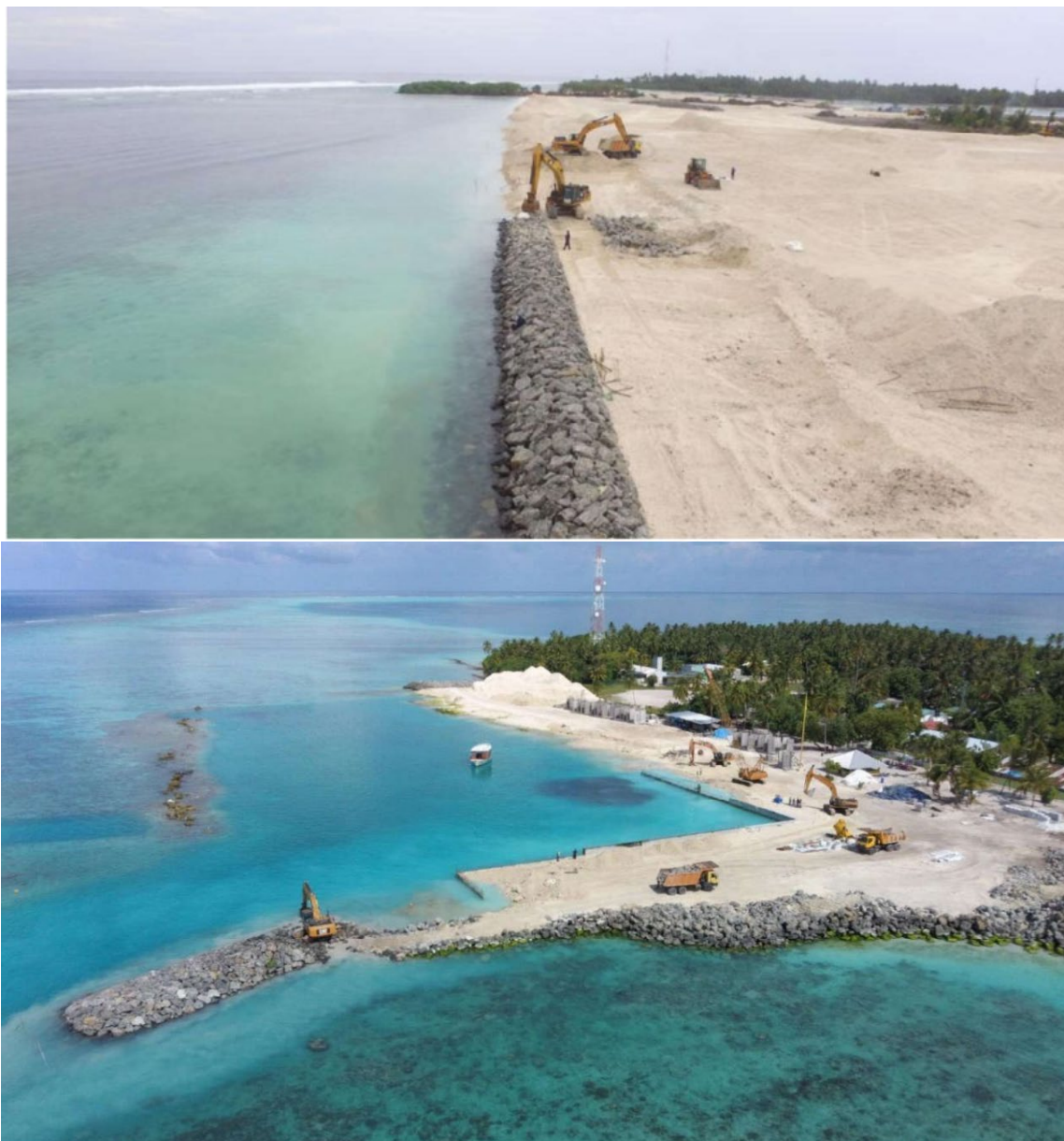
図 5.8.32 突堤・護岸の設置状況
