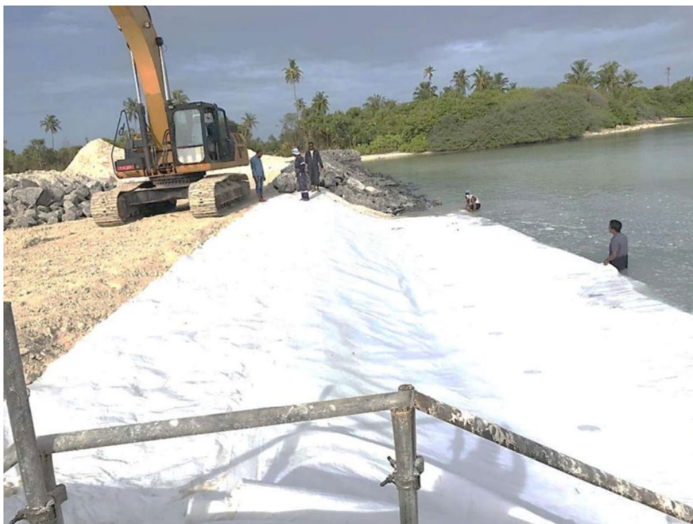
図 5.8.36 防砂シートの敷設状況
