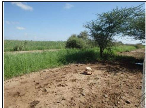
幹線水路の様子。雑草が繁茂しており、通水阻害を引き起こしている。
