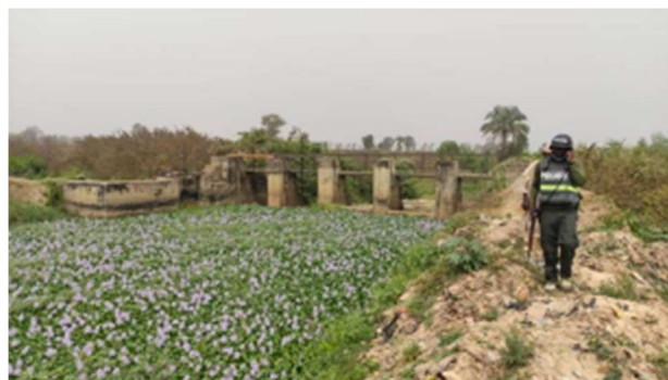
図 8.4 取水堰の様子
