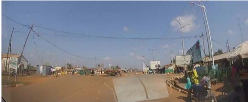
⑨N17 intersection Revêtement en asphalte (bon)
