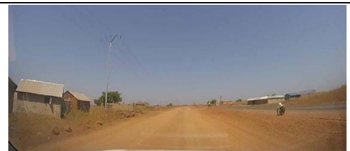
⑮N17 Section construction de Sadri
