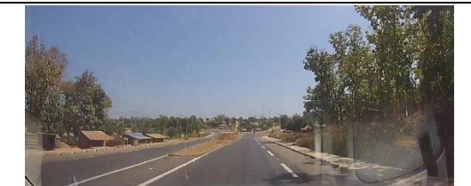
⑱N1 Revêtement en asphalte (bon)
