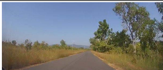
⑥N17 Revêtement en asphalte (réparé)
