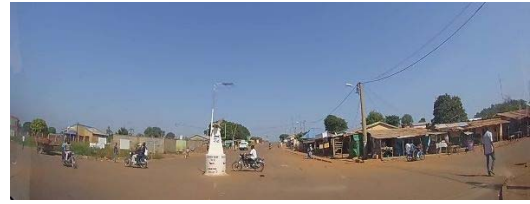
⑧N17, N19 Revêtement en asphalte (bon)
