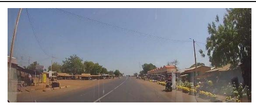
⑰N1 intersection Revêtement en asphalte (bon)
