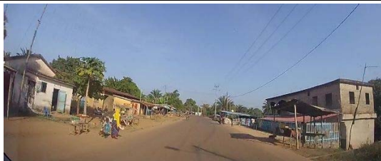
①N17 Sokode Revêtement en asphalte (bon)
