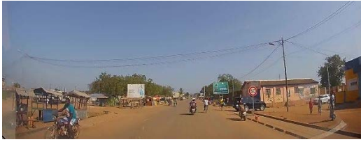
⑦N17Basari Revêtement en asphalte (bon)
