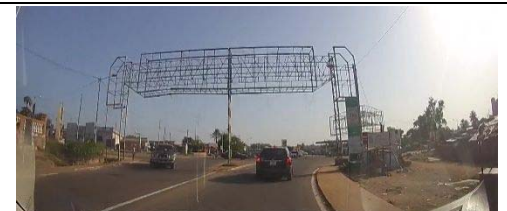
⑲N1-N16 jonction Revêtement en asphalte (bon)
