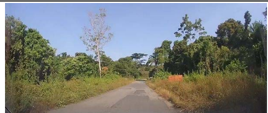
⑤N17 Revêtement en asphalte (réparé)
