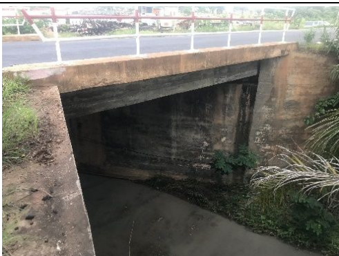
⑦ 既設排水施設の状況 国道 1 号の道路横断排水施設
