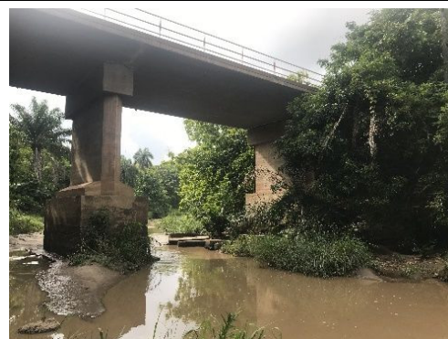
⑥ 既設排水施設の状況 国道 1 号の道路横断排水施設
