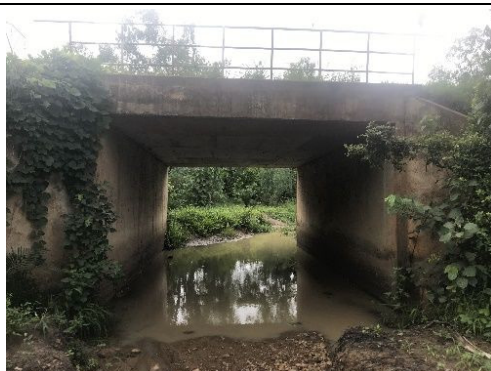
⑧ 既存排水施設の状況 国道 17 号の道路横断排水施設
