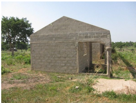
写真 2-2-3-7 建設中の建物
