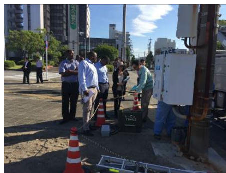
写真 4.2 信号維持管理現場視察
